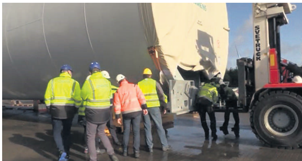
Den nye standardiserede fod passer til alle gængse typer møllesektioner på markedet. Den er lettere end tidligere versioner, og der kan spares op mod en hel dag alene i montagen, vurderer Advantis. Pressefoto
